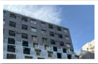
解体前の宮崎県東京ビル
